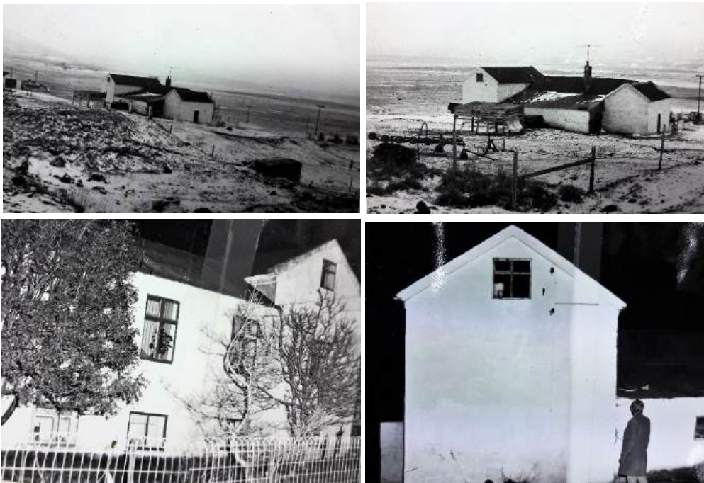
Efri röð: Bakhlið íbúðarhússins í október 1971. Á myndinni til vinstri sést rafstöðvarhúsið skammt norðan við bæinn, lágreist hús með skúrþaki. Neðri röð: Framhlið og norðurgafli íbúðarhússins. (Þí. Byggingastofnun landbúnaðarins 2005 A/198.)
