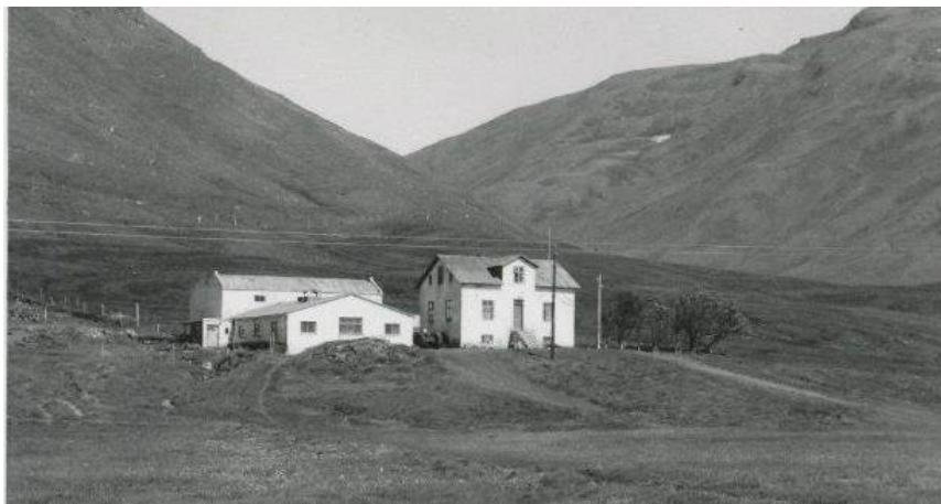
Auðólfstaðir um 1977. Norðvestan við húsið standa steinsteypt útihús, sem nú hafa verið rifin. (Ljósmyndasafn A-Hún.)
