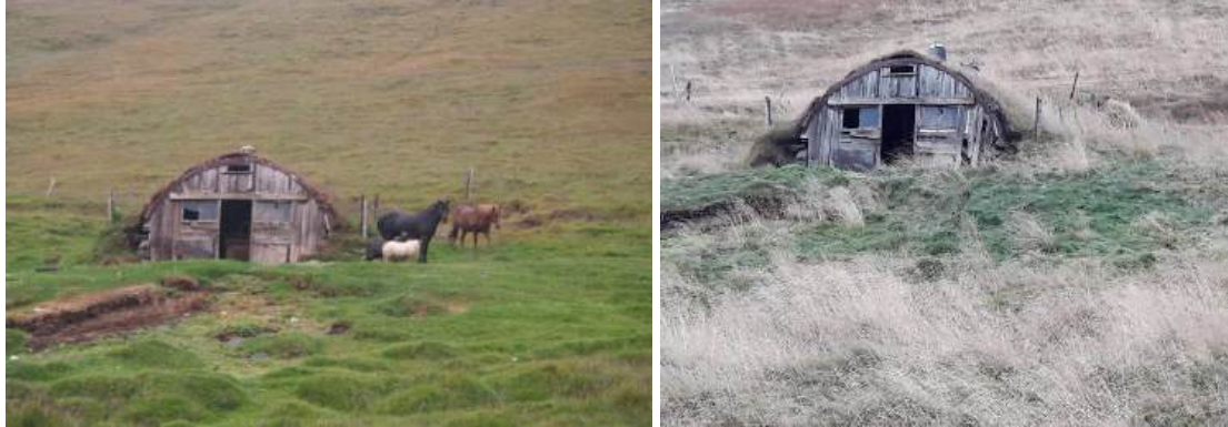
Hesthúsið er einn fárra stríðsárabragga, sem enn standa í Húnavatnshreppi. (Ljósmynd. Páll J. Línadal, 2015, og Gunnlaugur Haraldsson, 2018.)
