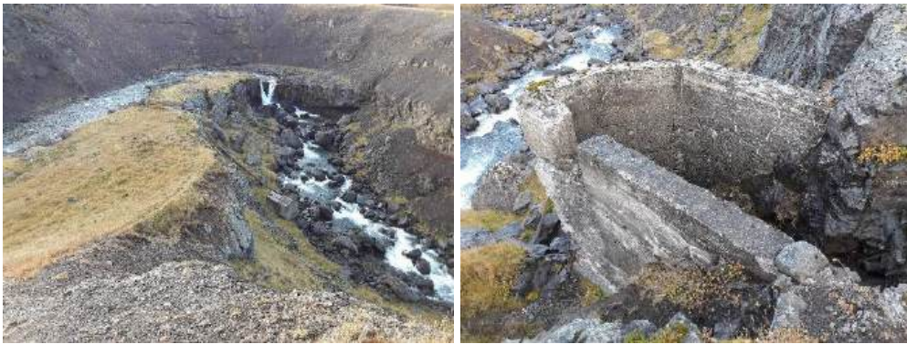
Rafstöðin í Giljargili 8. október 2018. Til hægri er steinsteypt þró, sem vatnið var leitt úr niður í stöðvarhúsið. (Ljós. Gunnlaugur Haraldsson.)
