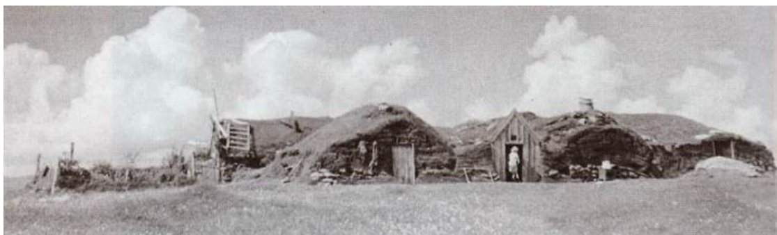
Gamli bærinn á Uppsölum sumarið 1936, en árið 1937 lauk búsetu í honum, er flutt var í nýja steinhúsið. Fyrir miðri mynd eru skemma og bæjardyr, en hlóðaeildhús hægra megin við þær. Baðstofan er baka til og snýr þvert á önnur hús. Blómagarður sunnan við húsið. (Schweizer, Bruno (2003 III), s. 342.)
