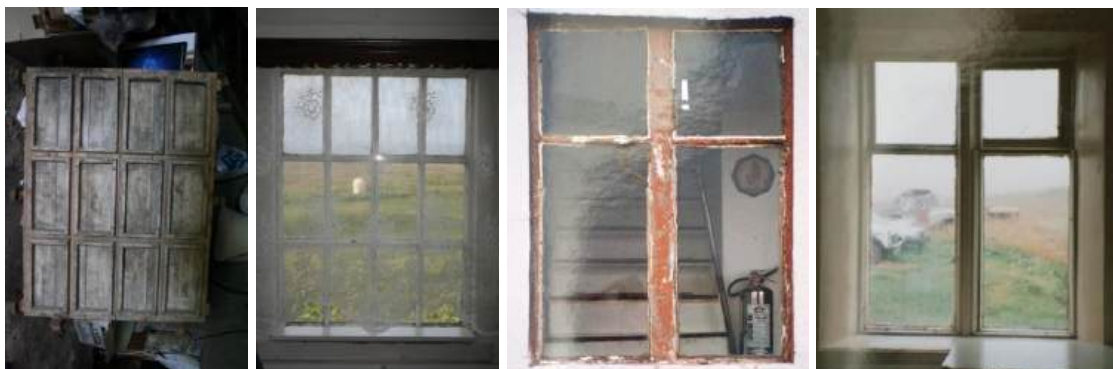
Gluggamót (t.v.) og tólf og fjöggra rúðu gluggar, sem ennþá eru í upprunalegri mynd í kjallara hússins. (Ljósmynd. Páll J. Línal og Guðrún B. Jóhannsson.)
