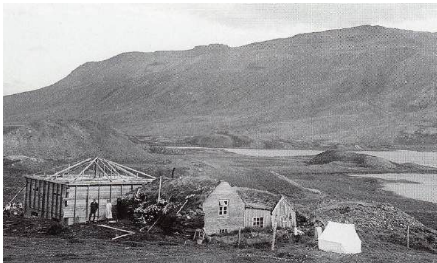
Vatnsdalshólar 1939. Nýja steinhúsið í byggingu, norðvestan við gamla bæinn. (Ættir Austur-Húnavetninga III, s. 1103.)
