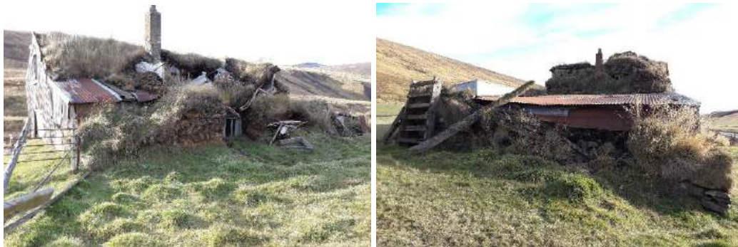
Til vinstri sést bakhlið (austurhlið) bæjarins og til hægri norðurhlið „geymslunnar“, sem er áföst norðurgafli framhússins. (Ljósmynd Gunnlaugur Haraldsson, 9. október 2018.)
