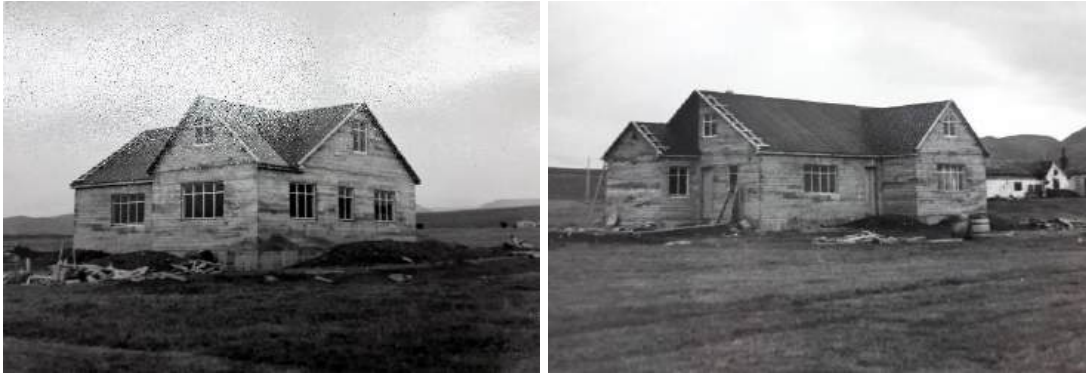
Íbúðarhúsið í byggingu árið 1953. (Þí. Byggingastofnun landbúnaðarins 2005 A/174.)
