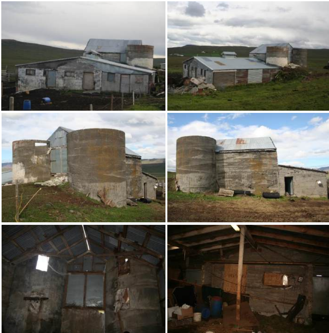
Myndin til vinstri sýnir suðausturstafn hlöðunnar að innanverðu, þar sem innbyggðir votheysturnar standa til sitt hvorrar handar. Til hægri sést steinsteyptur suðvesturgöfl fjóssins, sem síðar var breytt í fjárhús og nú er notað sem hesthús og geymsla. (Ljós. Páll J. Lindal, 2015.)
