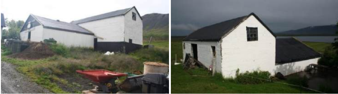
Fjóshlaðan var byggð 1951 og fjósið ásamt haughúsið 1952-1953. (Ljós. Páll J. Líndal, 2015.)
