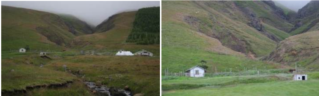
Vestan við Gíslækinn standa steinsteypt hesthús á gamla bæjarstæðinu og rafstöðvarhús nokkru neðar á lækjarbakkanum. (Ljós. Páll J. Lindal.)
