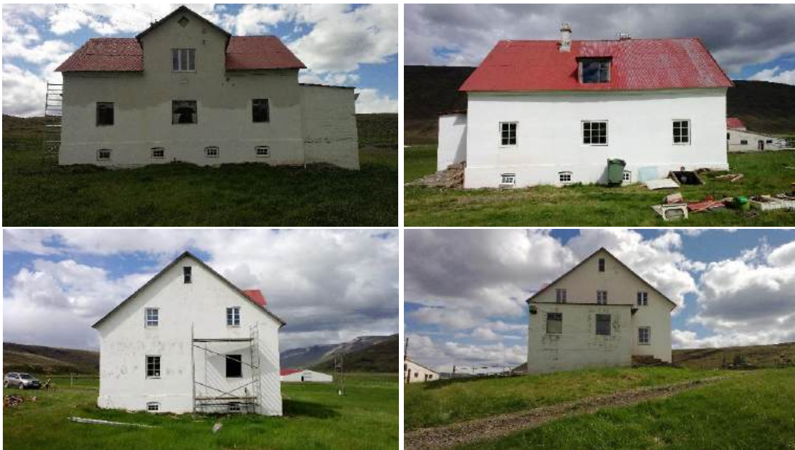
Íbúðarhúsið í Grímstungu 18. júní 2013, skömmu áður en hafist var handa við endurbætur á því. Allmargir gluggar höfðu þó verið endurnýjaðir. (Ljós. Stefán Árnason.)
