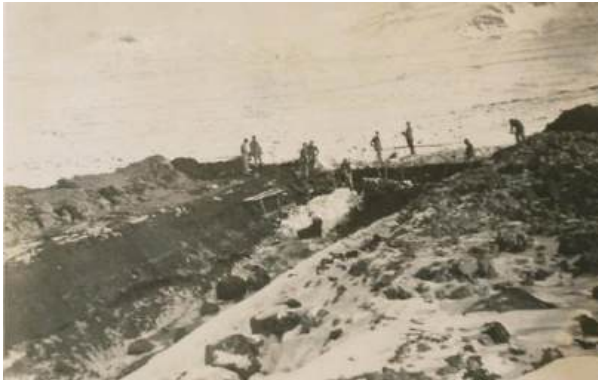
Framkvæmdir við gerð Laxárvatnsstíflunnar 1933. (Ljósmyndasafn A-Hún.)
