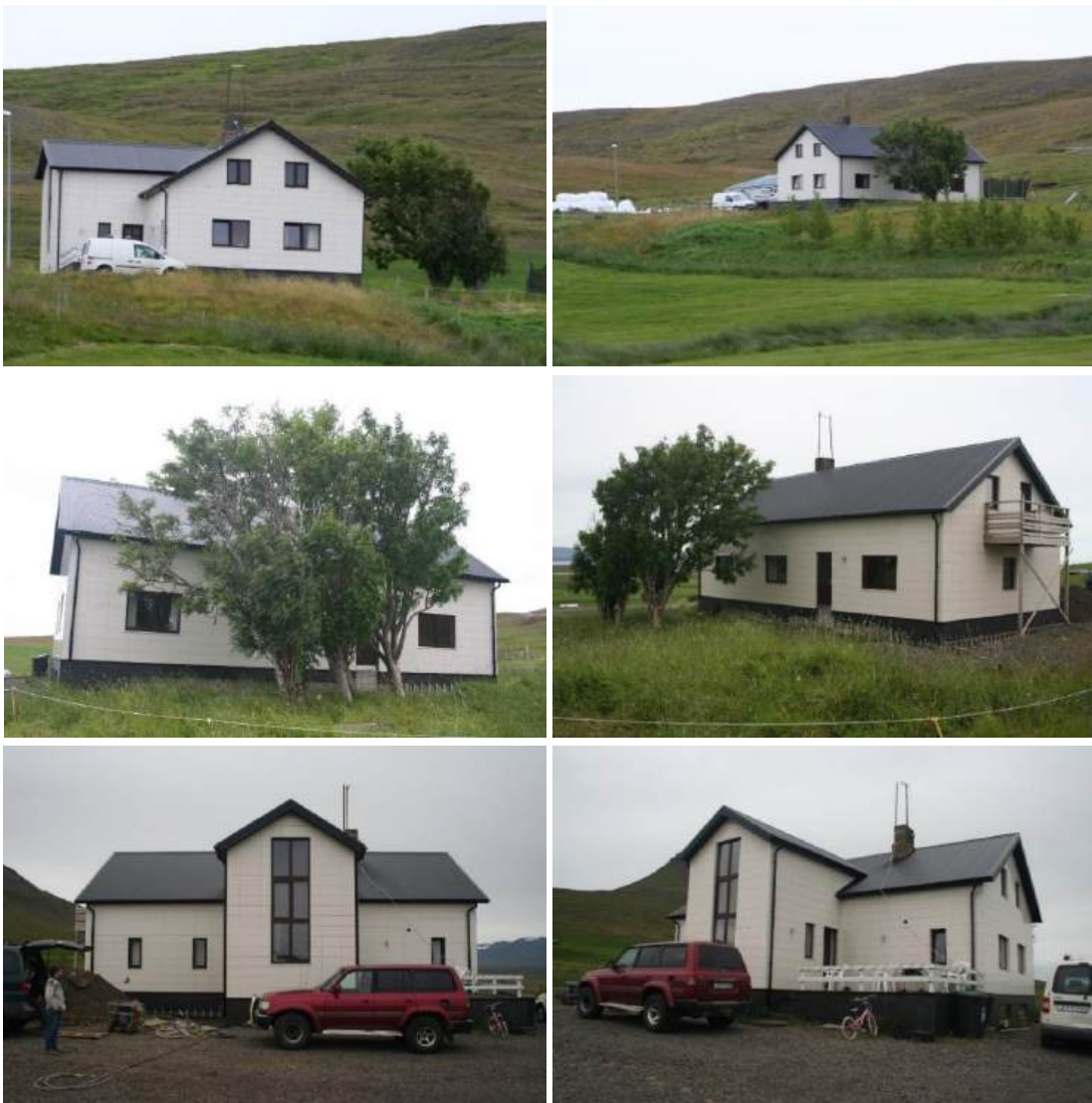
Gamla steinhúsið myndar nú vesturenda hússins eftir að það var stækkað með viðbyggingu til austurs og stigahúsi við norðurhlið. (Ljósmynd. Páll J. Lindal, 2015.)
