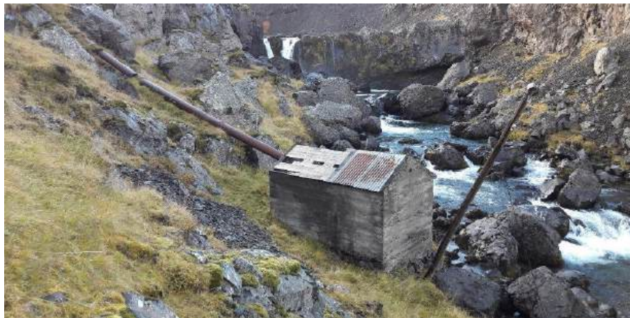
Rafstöðvarhúsið á Stóru-Giljá er eitt þriggja mannvirkja af þeirri gerð, sem ennþá standa í Húnavatnshreppi.
