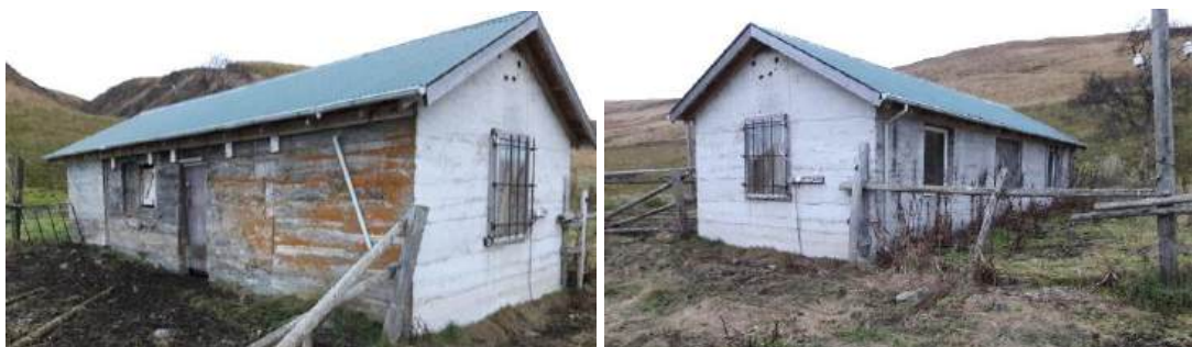
Steinsteypt hesthús á gamla bæjarstæðinu var byggt upp úr íbúðarhúsinu, sem byggt var 1939 og brann 1963. (Ljós. Gunnlaugur Haraldsson.)
