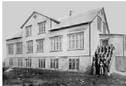
Gamla Kvennskólahúsið á Blönduósi reist 1901. Það brann 1911
