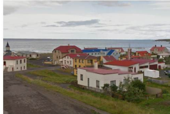
Mynd frá 2013 - horft yfir þorpið til sjávar - Búið er að jafna við jörðu hús nr. 15, sem var fjarlæggt 10. júní 2008
