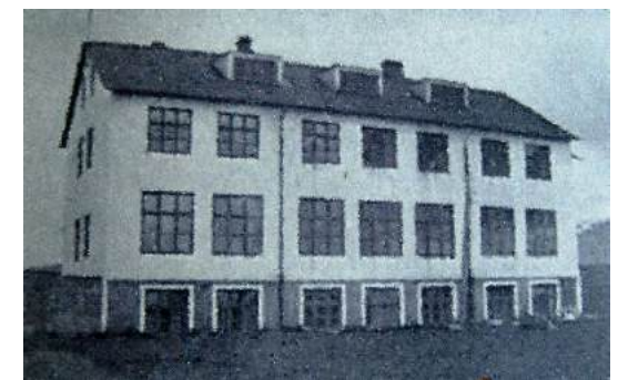
Á myndinni má sjá 3 kvisti á garðhlið hússins og að búið er að fjarlægja einhverja reykháfa (ártal óvísst)
